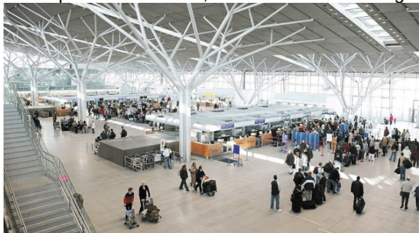
Abbildung 1: Komplexe Stahlkonstruktion des Flughafengebäudes Stuttgart, [1].
