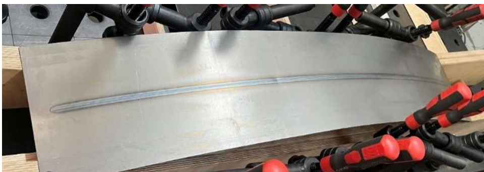
Abbildung 4: Unterseite eines Feiblechs mit aufgeschweißter Rippe
